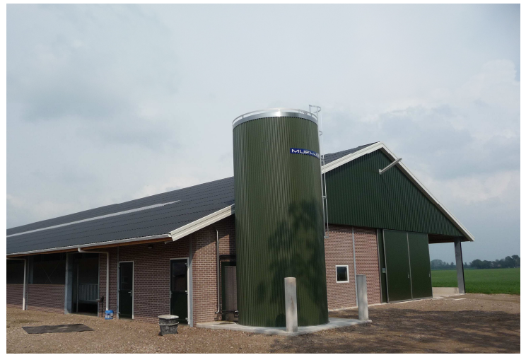
Silo 34 damwand groen
